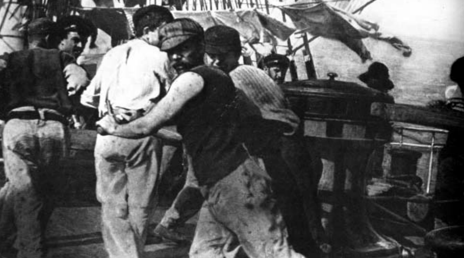
Arbeit am Gangspill (der Ankerwinde), bei der oft ein Gangspill-Shanty zur Unterstützung des rhythmischen Ablaufs gesungen wurde (Edition André Bonne)
